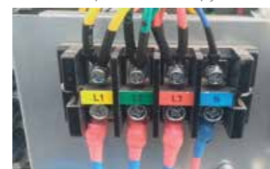
Клеммы электропитания наружного блока
